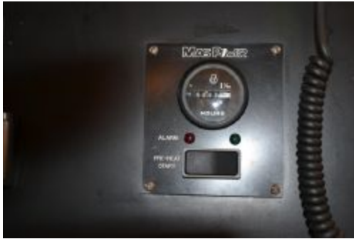
Generator Hour meter
