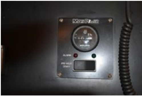
Generator Hour meter
